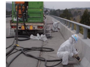
2人同時作業(橋梁高欄部の処理)
