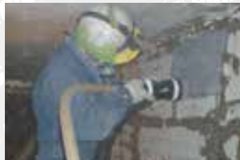
▲ 橋梁での作業の様子
