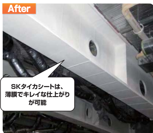
スリーブ貫通部
