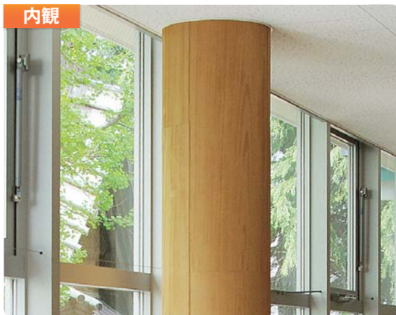
SKタイカシートを施工後、シート建材を施工
