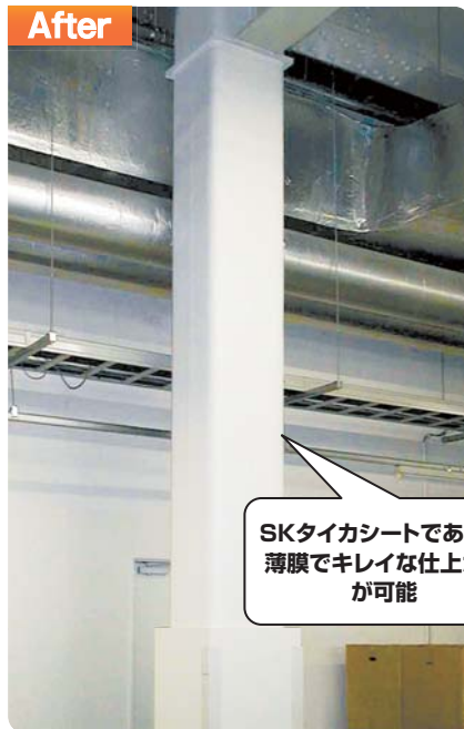
けい酸カルシウム板を撤去後、 SKタイカシートを施工
