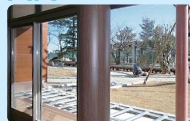
仕上例2:塩ビシート貼り及びシート建材貼り
