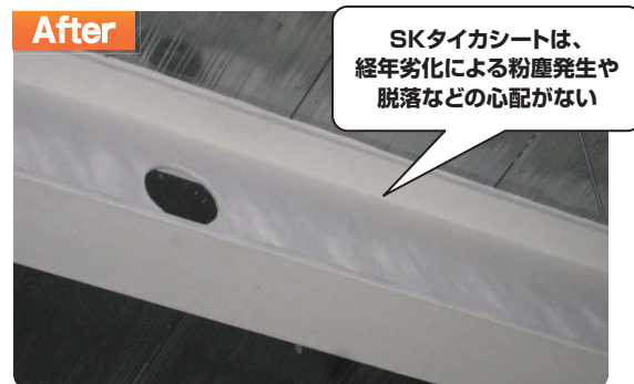
ロックウールを撤去後、SKタイカシートを施工
