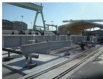
現場ヤード施工
