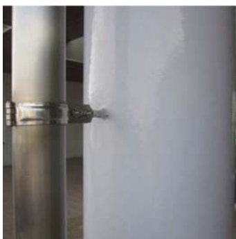
▼ドレンパイプの取合い部分
