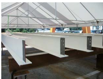
工場プレコート施工
