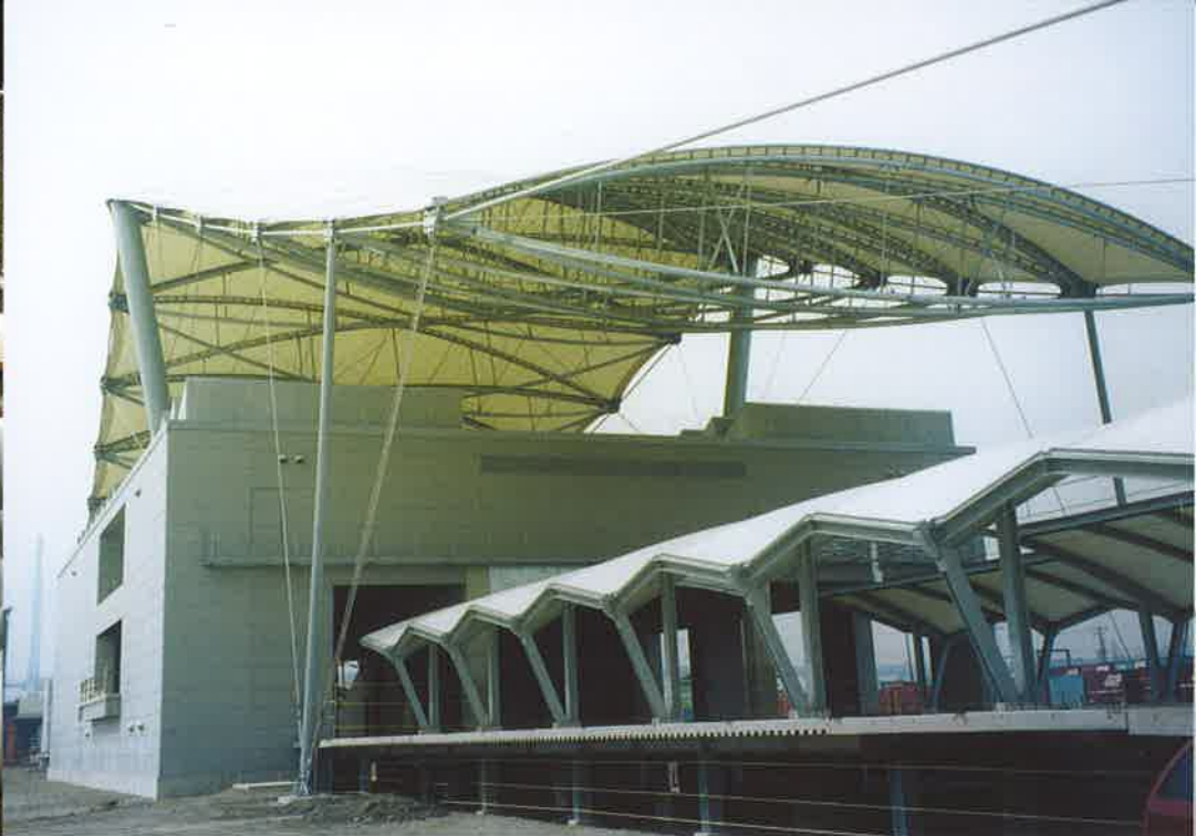
建築鉄骨へのZRC
