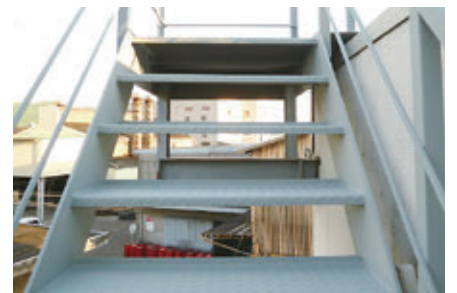
外部鉄骨階段
