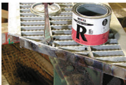
グレーチング 溶接部補修
