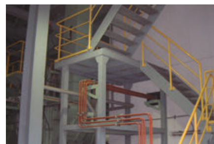
ごみ処理プラント 鉄骨全面塗装
