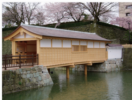
御廊下橋(福井) ZSクリアーII 塗装
