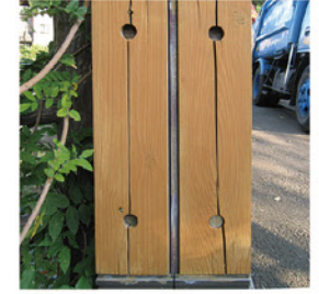
水洗→リグノブライート1回塗り →ノンロット2回塗り
