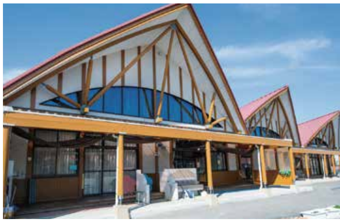
愛南町立城辺保育所 (愛媛県) キシラデコールコンゾラン ピニー使用
