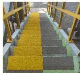
封鎖できない階段の塗り方
