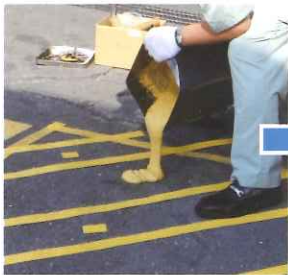
混合したすべり止めコートを塗布面に直接垂らします。
