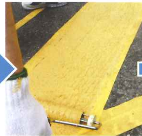
専用のローラーを用いて塗布面にパターン（凸凹）付けし、仕上げます。
