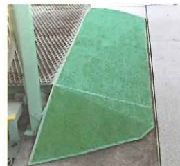
編鋼板のスロープ
