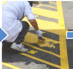
塗布面をゴムベラ等で均一にし、約1~2mm厚程度に塗り広げます。
