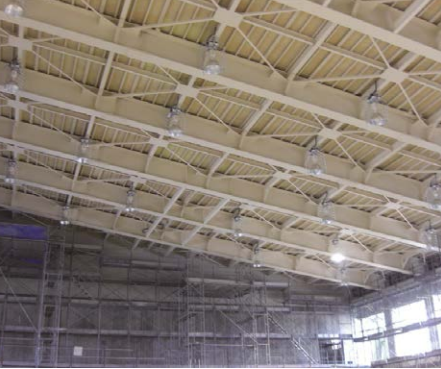
体育館 鉄骨梁
