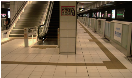
地下鉄駅ホームの保護 福岡市営地下鉄：天神南駅
