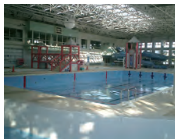
ウォーターパレスKC(愛知県刈谷市)
